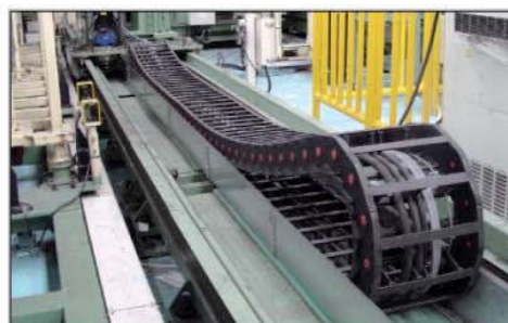
⬆ Сварочная линия сборки транспортных средств
