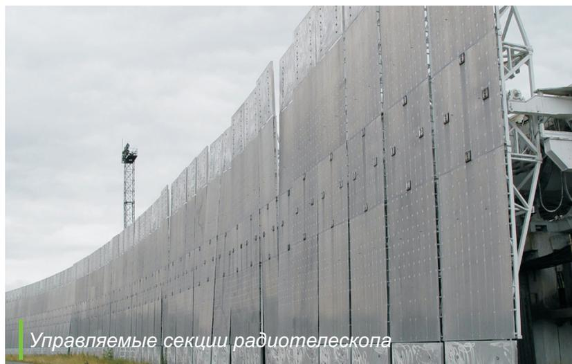
Управляемые секции радиотелескопа
